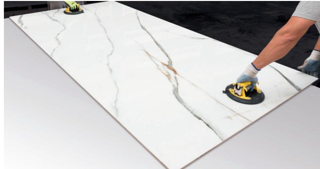
Para realizar el corte de la pieza de gran formato, debemos disponer de una superficie plana de por lo menos el tamaño del material a cortar y que esté totalmente limpia de residuos e irregularidades. Se recomienda que la manipulación de las piezas de gran formato sea ejecutada por más de una persona, así como el uso de las ventosas adecuadas para un correcto agarre del producto.
